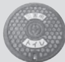
マンホールトイレのふた
