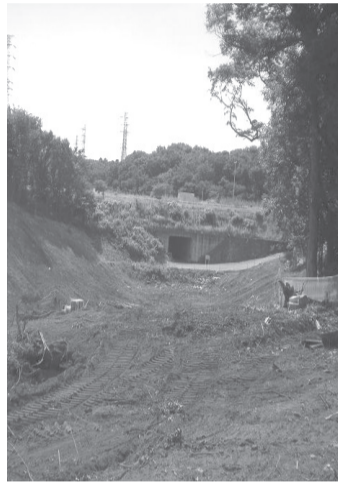
▲ 伐採された森。 トンネル上が国道51号線バイパス。貝塚インター手前300M
