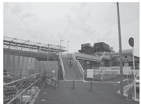
工事中のJR千葉駅西口
